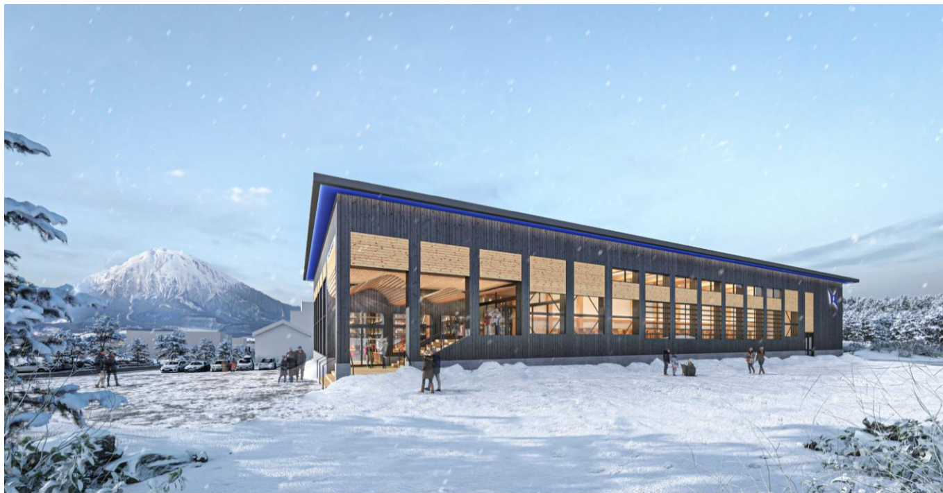
ALPEN NODE 冬季外観イメージ（一部変更の可能性あり）
